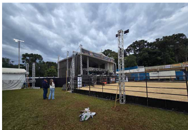
As equipes de fiscalização também atuam em obras instaladas para eventos, garantindo um ambiente seguro para todos
