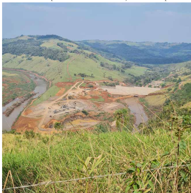
A Regional Guarapuava também faz um trabalho importante na fiscalização de usinas hidrelétricas
