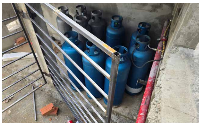
Centrais de gás, igualmente, passam pela vistoria técnica de fiscalização
